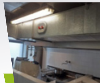
Dégraissage du réseau de gaine (sous réserve d'accessibilité)
